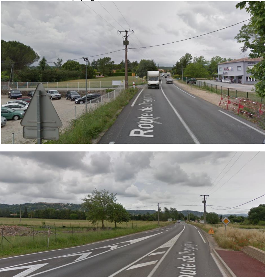
Figure 6 : Entrée de ville depuis la D562 à l'Est (en haut) et à l'Ouest (en bas) (Source : Google Street)
