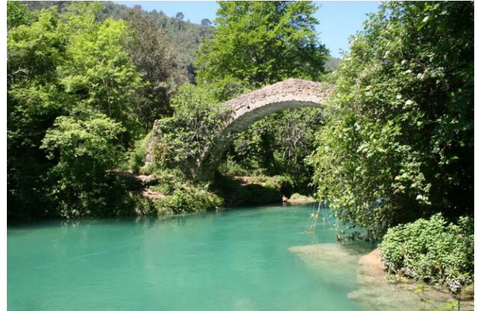
Figure 10 : Pont des Tuves (Source : Pays de Fayence)
