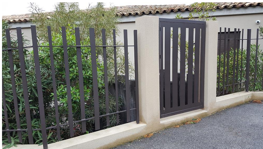
Exemple de traitement cohérent entre la clôture et le portillon
