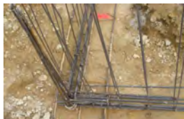
Nœud de chaînage - Continuité mécanique
